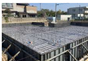
▲べた基礎 配筋組
